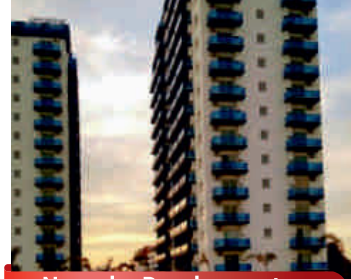
Noyanlar Development Split Klima Sistemleri
