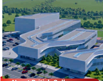
Necat British College VRF ve Isı Pompası Sistemleri
