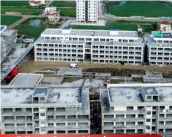
Döveç Court Yard Multi Klima Sistemleri
