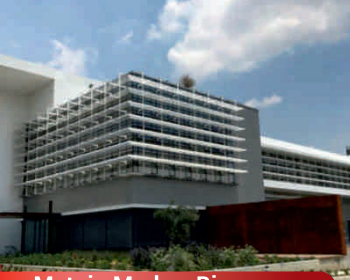
Metgin Merkez Bina VRF ve Isı Pompası Sistemleri
